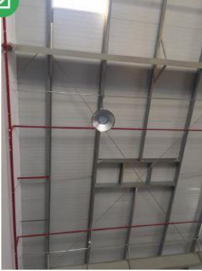
شكل رقم (19): سقف من الألواح المعدنيّة
