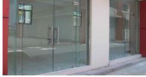
شكل رقم ١٤: باب مزدوج بعرض ١٦٠ سم
