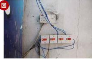
شكل رقم ٦: الأسلاك والأنابيب الخارجية المكشوفة
